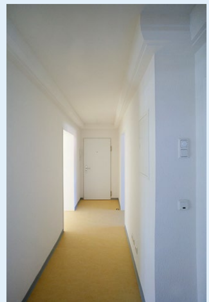
Abbildung 18: Flur nach der Sanierung
