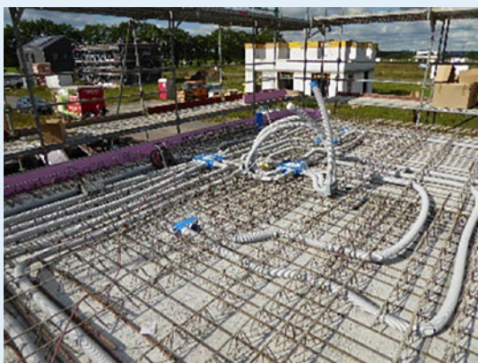
Abbildung 7a: Verlegung der Leitungen in der Decke
